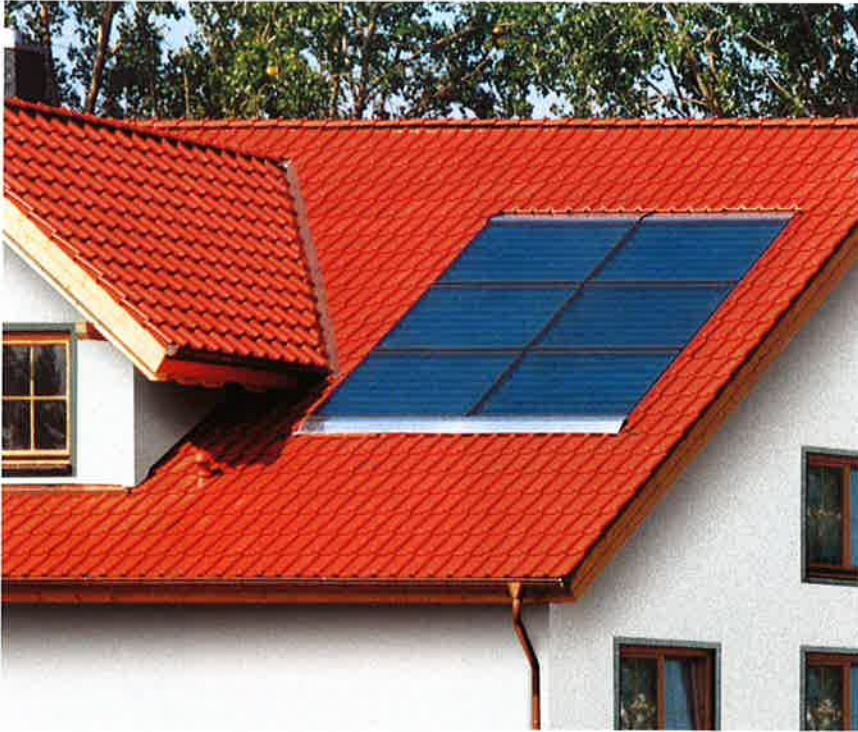
Perfecta integración en el tejado de los colectores solares de Weishaupt (sistema encastrado)
