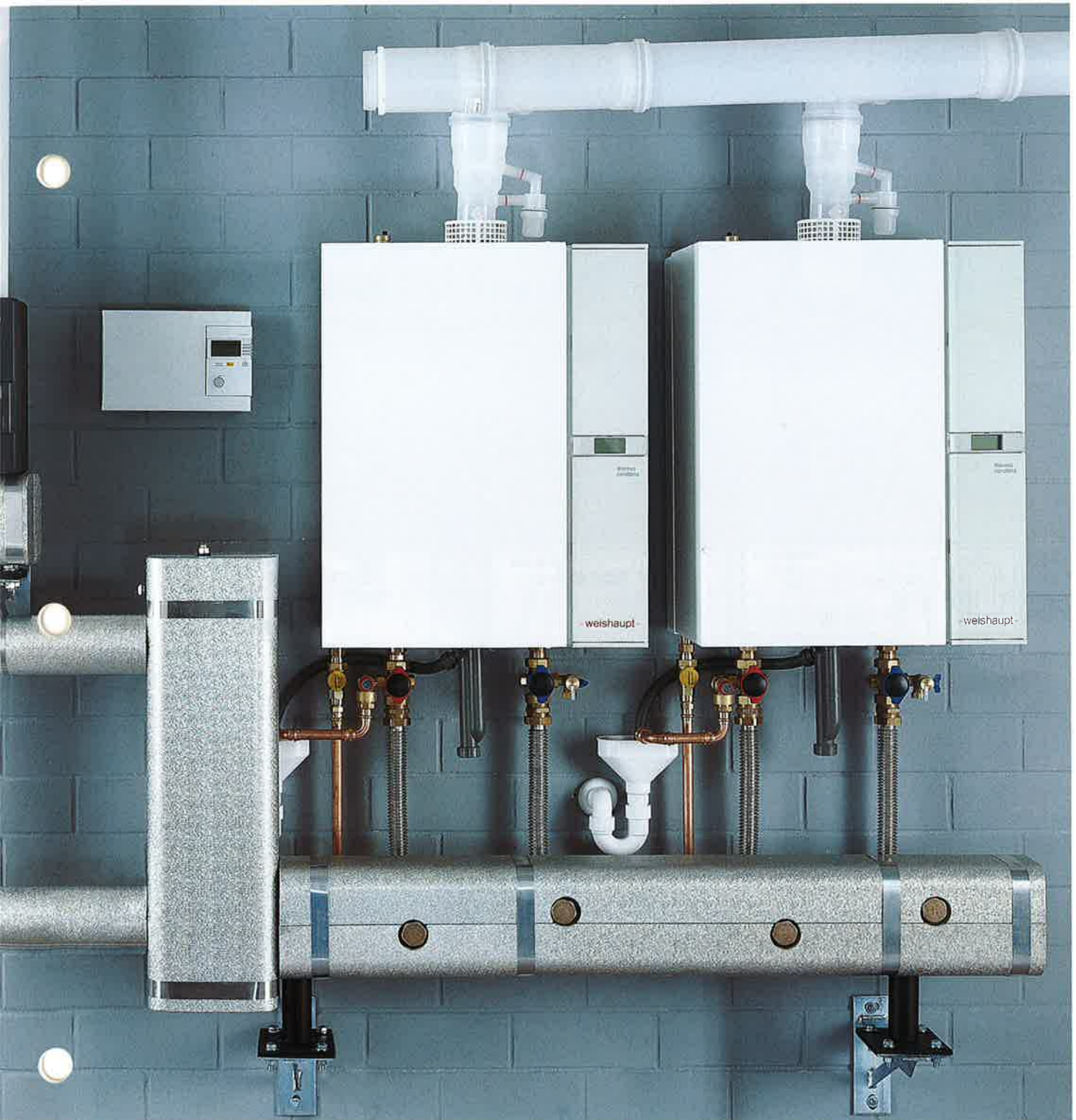
En una cascada de Thermo Condens con 240 kW la potencia mínima de modulación comienza en 5%, aumenta sin escalones en función de la demanda hasta la potencia total
