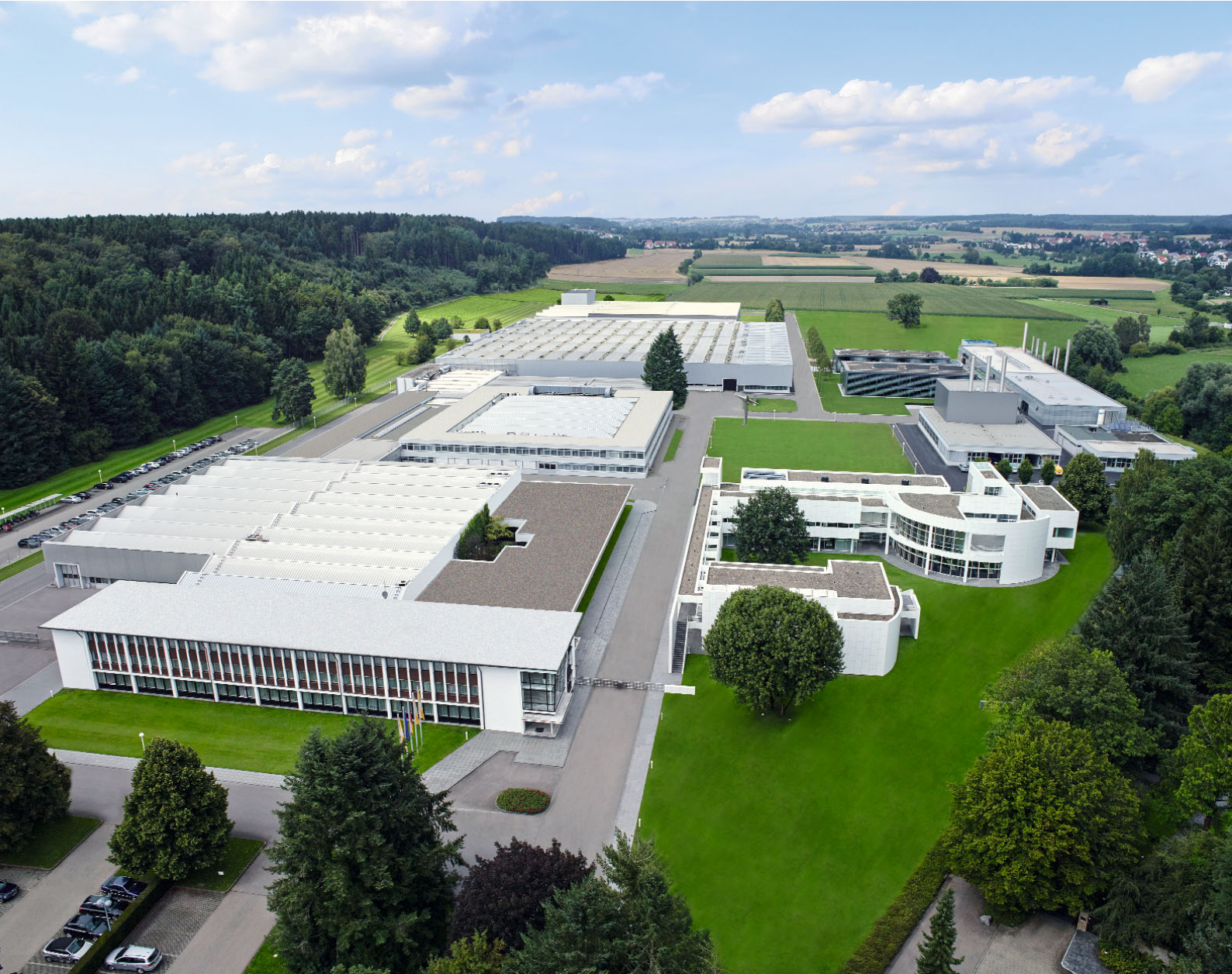
Administración, fabricación de quemadores, construcción de cuadros eléctricos e investigación en la sede central en Schwendi
