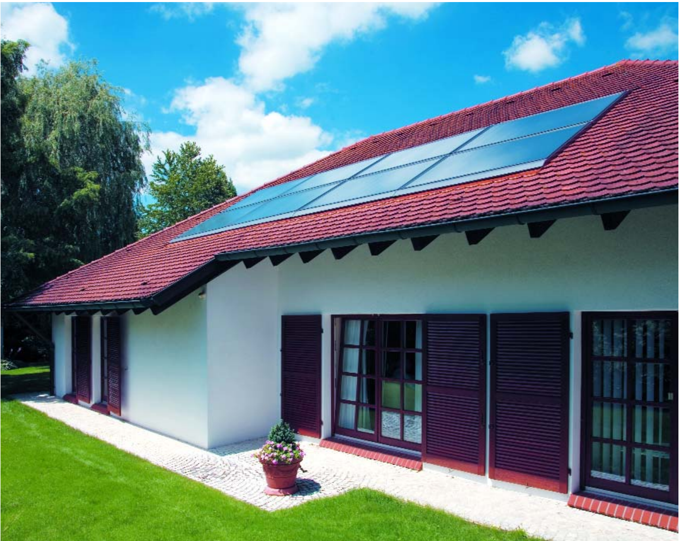
Campo de 8 colectores, encastrado, horizontal
